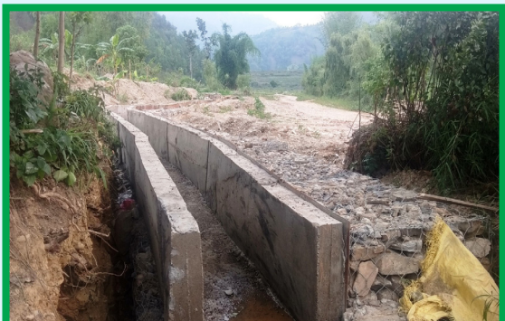
शहरी जलाधार क्षेत्र संरक्षण कार्यक्रम, ५० मी लामो आर सी सी सिँचाइ कुलो निर्माण तथा तटबन्धन, अर्घाखाँची
