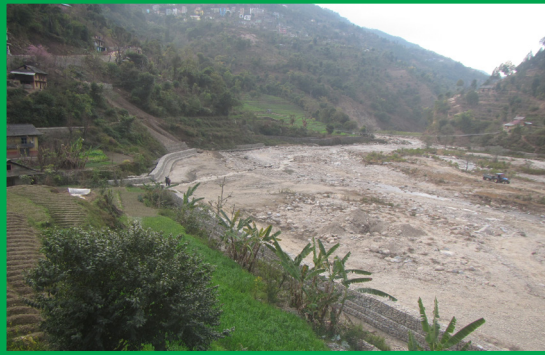
रोल्पा नगरपालिका-४, धाडसीखोला, खोला किनार संरक्षण, २०७५/०७६
